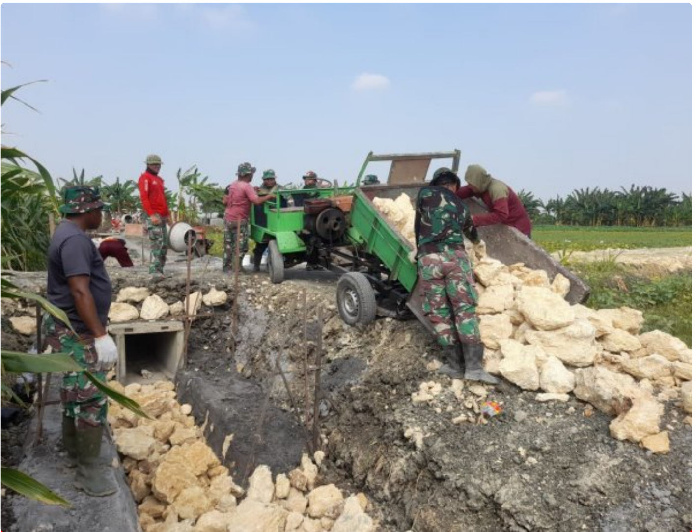
Satgas Dan Warga Menurunkan Material Yang Dimuat Menggunakan Grandong
